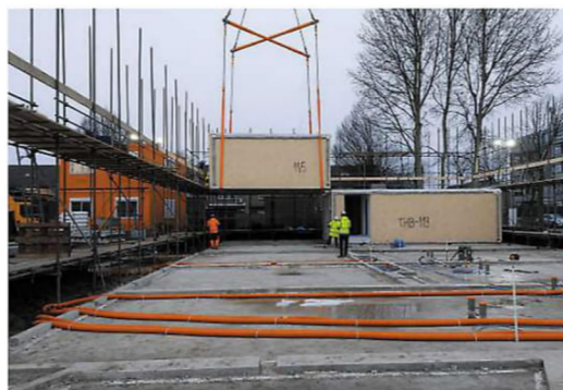
De modules worden op de plaats van bestemming in serie geschakeld en meerlaags opgebouwd. PETERS BOUW
